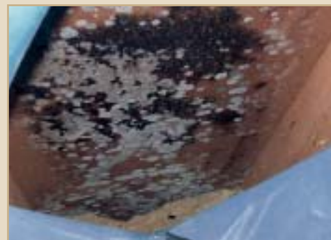
Sedlbauer a Krus (3) udávají pro dosažení podmínek pro růst téměř všech druhů plísni relevantních pro stavební prostory relativní vlhkost vzduchu 80 %. Optimální oblast leží dle druhu plísně mezi 90 % a 96 % relativní vlhkosti vzduchu.
