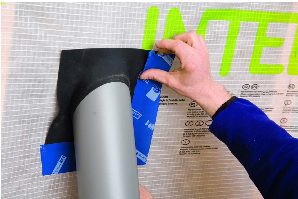
Obrázek: Použití parobrzdy pro clima INTELLO v kombinaci s těsnícím kroužkem ROFLEX a páskou TESCÓN No. 1.
