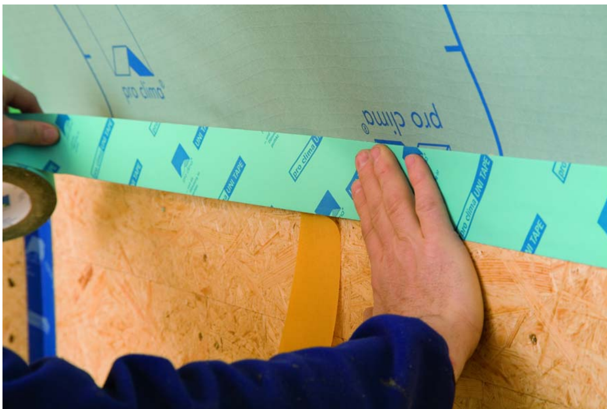
Obrázek: Použití pásoviny pro clima DB+ v kombinaci s lepicí páskou UNI TAPE v půdních prostorech.
